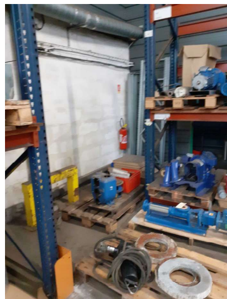
Extincteur dans le bâtiment B dont l'accès est encombré
